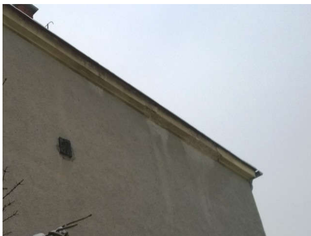
Porušená omítky na a pod římsou východní fasády objektu
